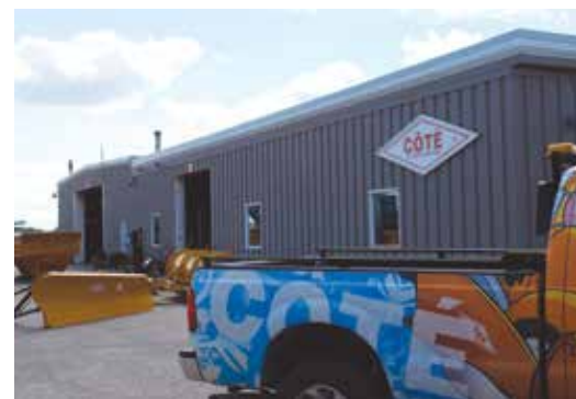
> L'usine de la rue Côté à Mercier.
